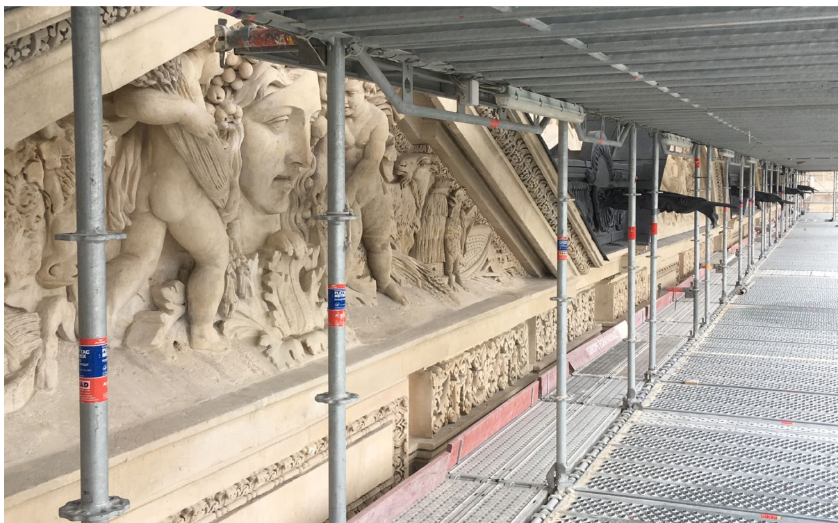
Travaux dans l'aile du Bord-de-l'Eau
